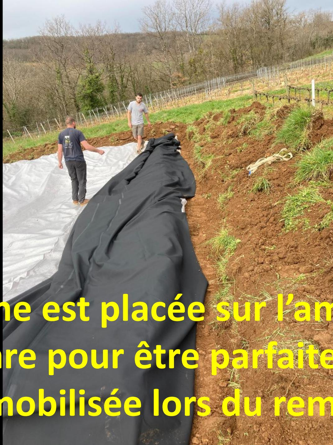
**La bâche est placée sur l'amont de la mare pour être parfaitement immobilisée lors du remblai**
