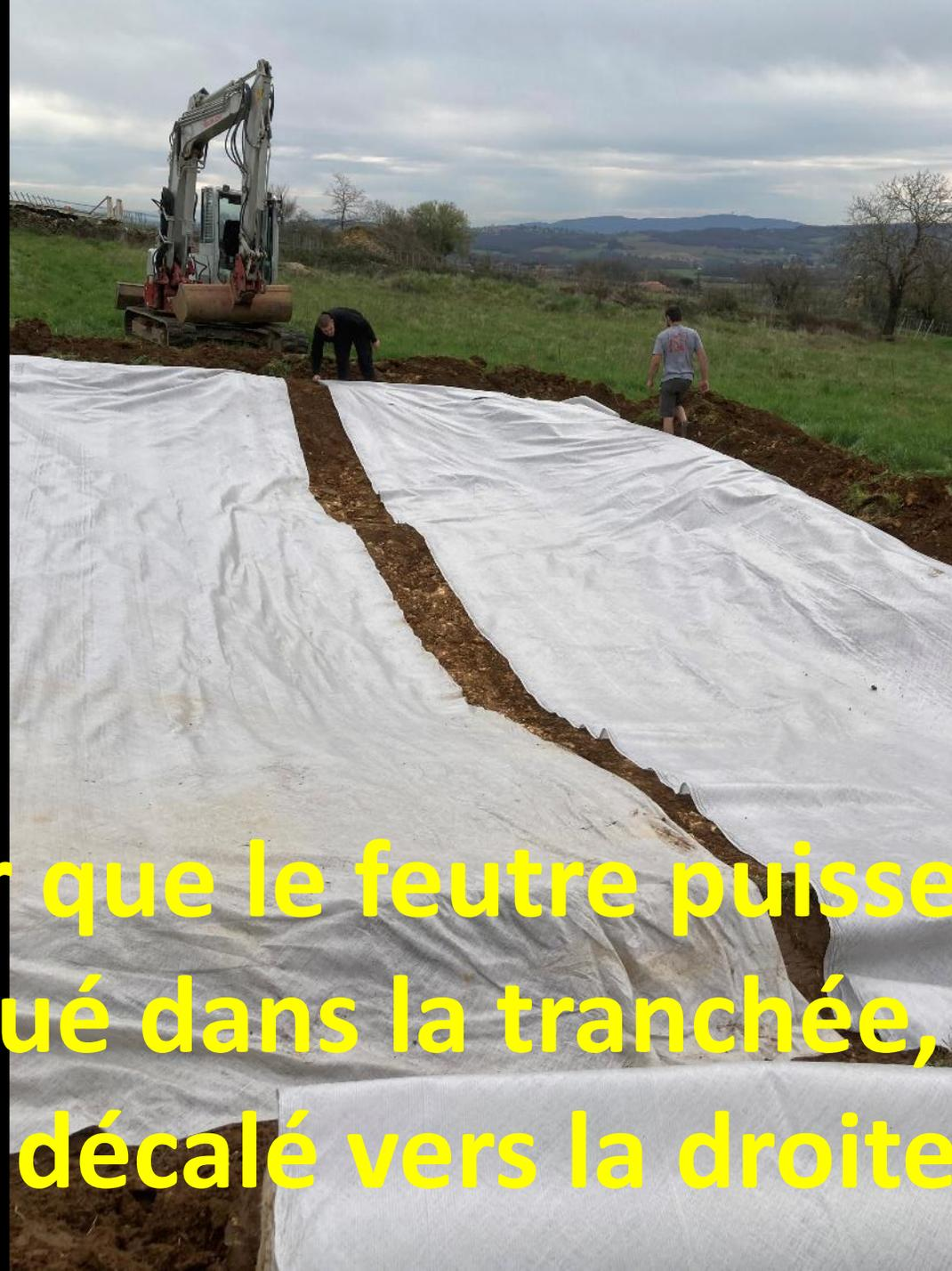
**Pour que le feutre puisse être bloqué dans la tranchée, il est décalé vers la droite**
