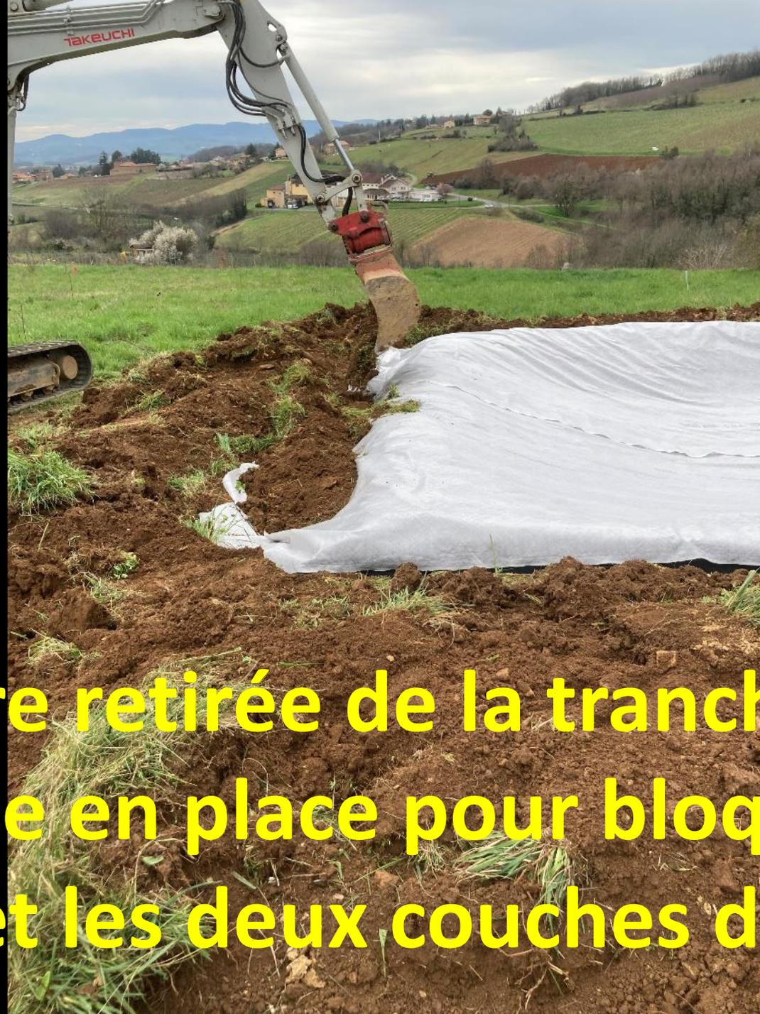
**La terre retirée de la tranchée est remise en place pour bloquer la bâche et les deux couches de feutre**
