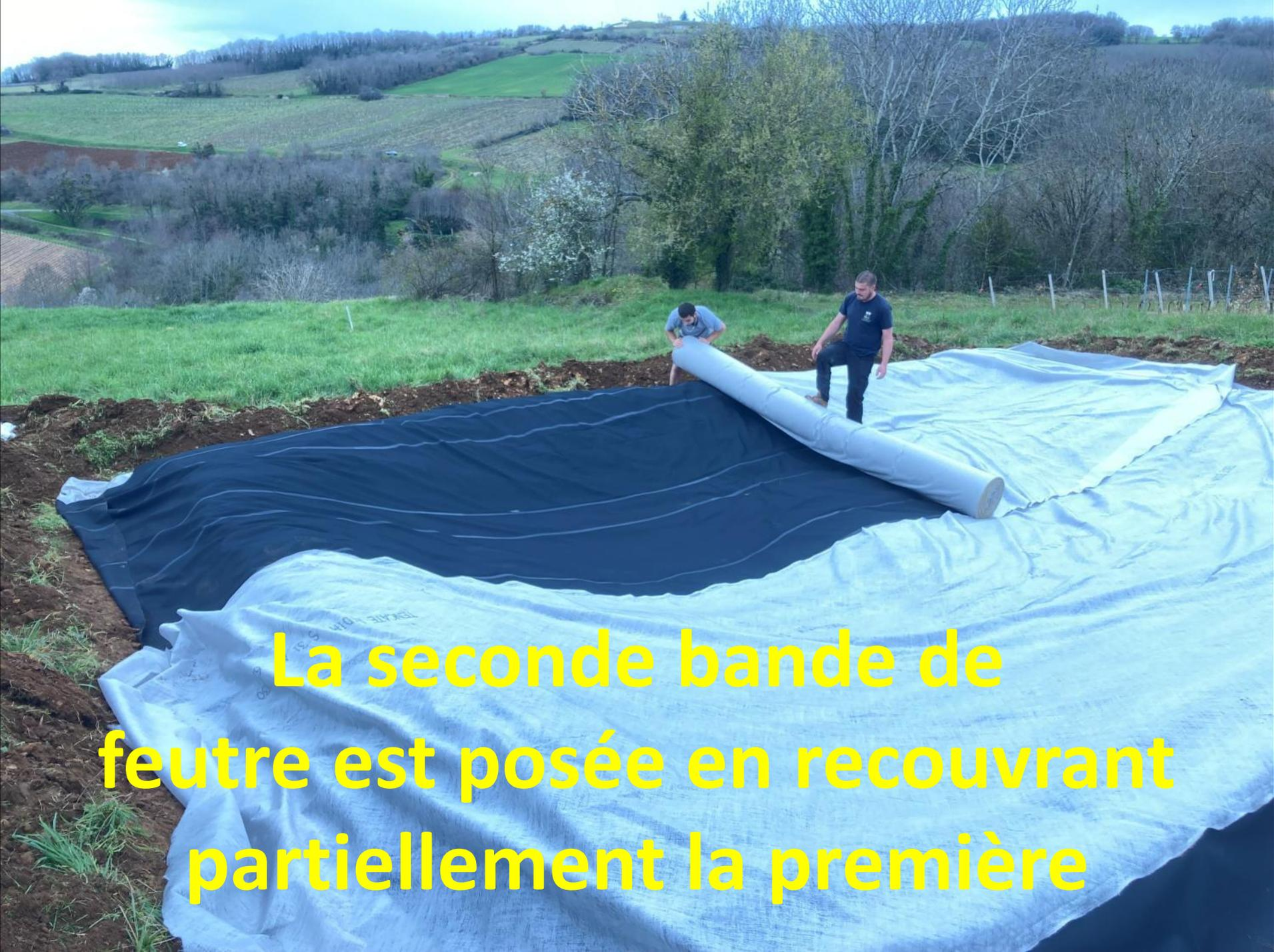
**La seconde bande de feutre est posée en recouvrant partiellement la première**
