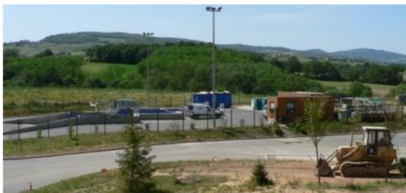
Déchèterie de Theizé
