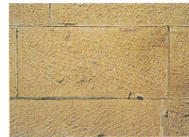
appareil réguliers = restauration des joints
