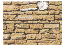
appareil irréguliers/assisé = enduit à pierres vues ou enduit couvrant
