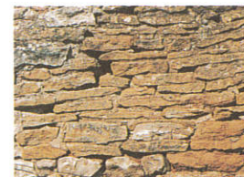
appareil non assisé = enduit couvrant
