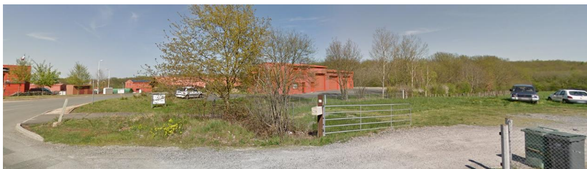
Vue depuis la route d'Alix : secteur d'extension phase 1 en second plan derrière les constructions
