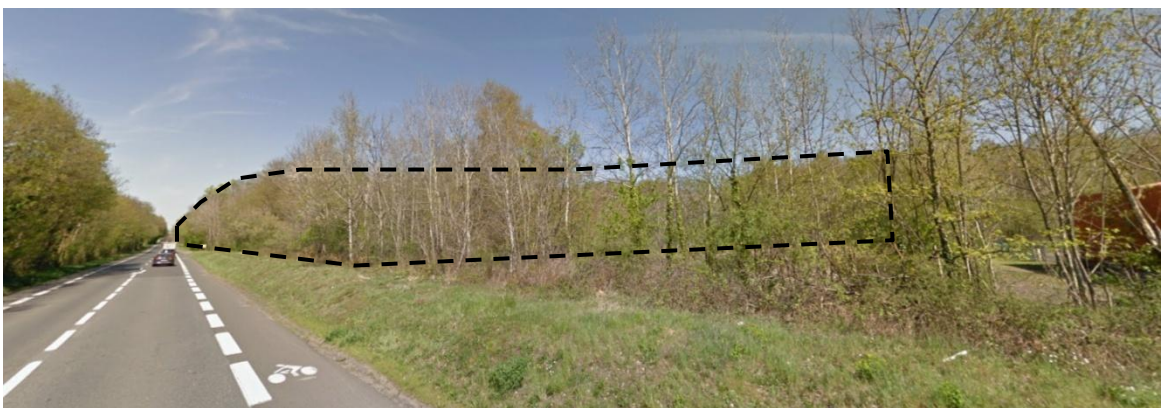
Boisements correspondant à la 2 ème extension avec une construction de la ZA et le bassin de rétention des eaux pluviales au 1 er plan à droite
