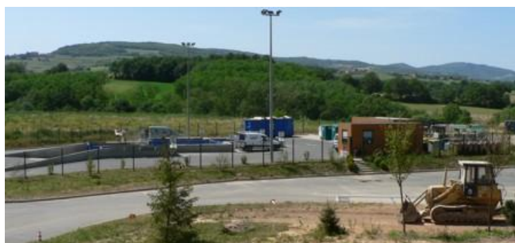
Déchèterie de Theizé
